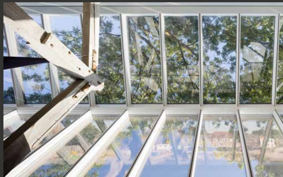
Gewerbehalle Isartal, Munich, Allemagne
