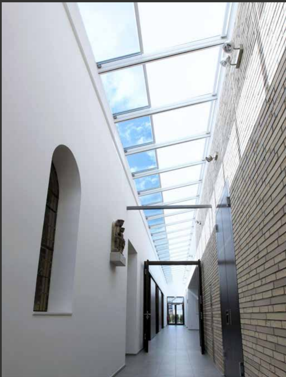
Église, Erkelenz, Allemagne
