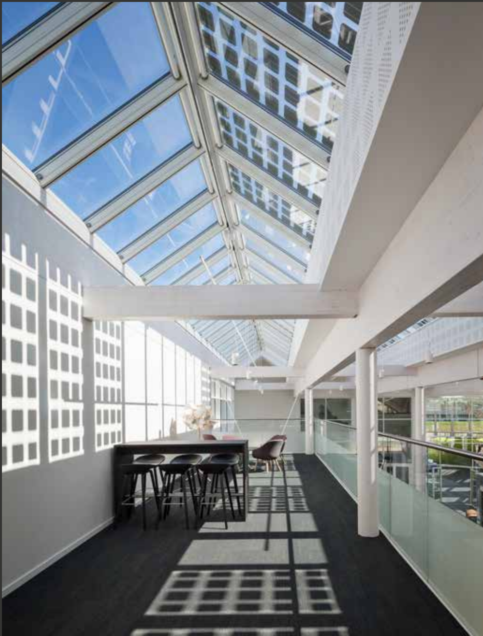
Green Solution House, Bornholm, Danmark (à droite: vitrage photovoltaïque)
