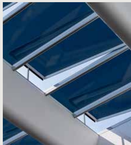
Vitrage avec verre Electrochrome Taux de transmission de lumière visible 1%
