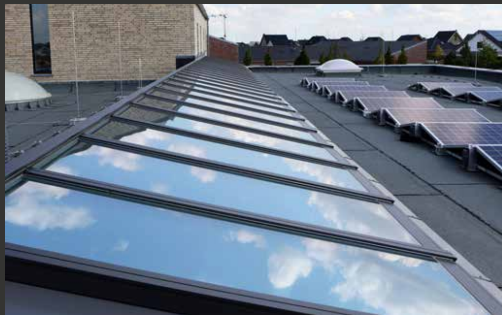
Église, Erkelenz, Allemagne
