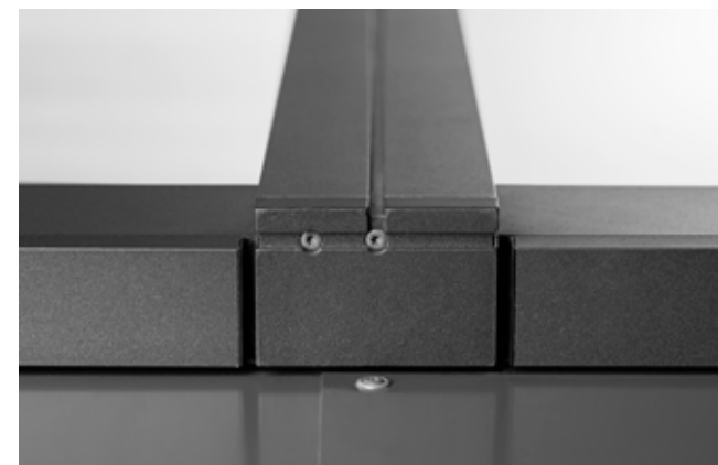
Assemblage de revêtement et de raccordement à l'avant du lanterneau.
