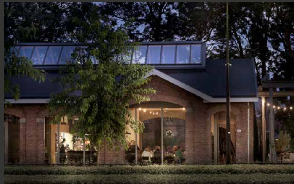
Gewerbehalle Isartal, Munich, Allemagne
