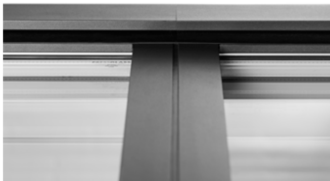
Assemblage des revêtements des parties médiane et supérieure. Lanterneau 5 – 25°.
