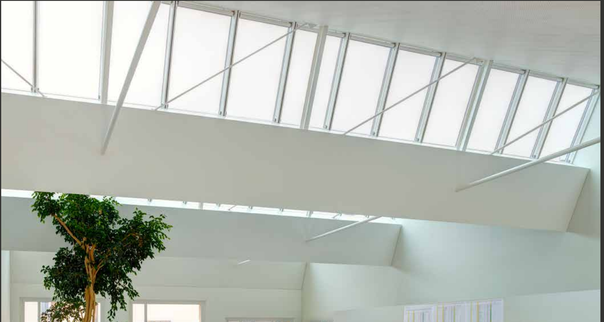
Industrie Zimmerlistrasse à Zurich, Suisse
