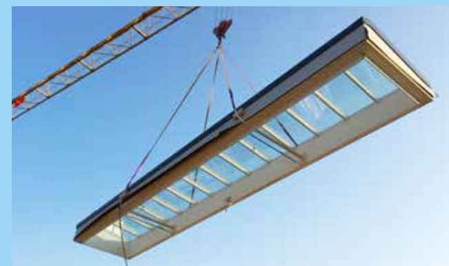
Élément préfabriqué de HP Gasser AG, Lungern
